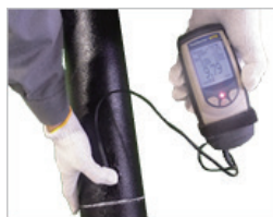
(1) 既設管 管厚測定 ※超音波測定器
