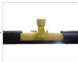
(5) 作業完了 窓開け・サーチ設置状況
