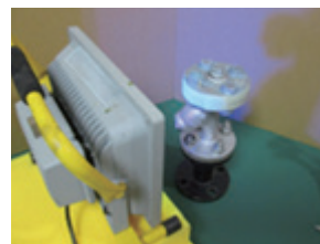
3. UV-FRPシートに、太陽光または紫外線照射ライトを照射し、硬化処理。 (1面15分程度)
