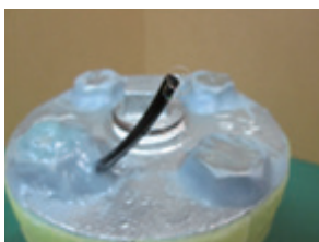
4. 硬化後、漏えい部にアクリル系接着剤にてホースの固定。
