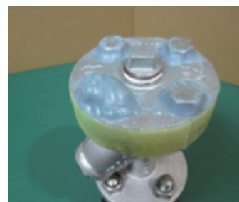
3. UV-FRPシートに、太陽光または紫外線照射ライトを照射し、硬化処理。 (1面15分程度)
