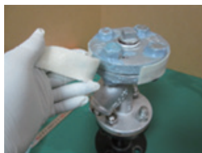
2. 漏えい部以外のボルト/ナット部に2液混合のアクリル系接着剤、フランジの突合せ部にUV-FRPシートを貼付。
