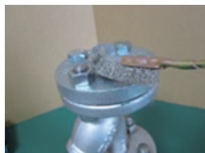
1. 漏えい部を特定後、フランジ部を清掃。
