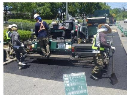
再生アスファルト合材による舗装
