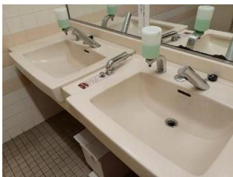
センサータイプの節水機器
